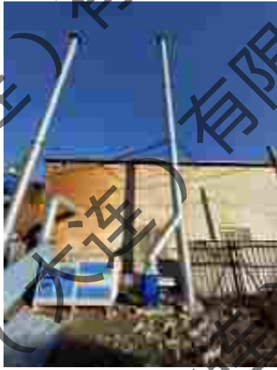
图 3-2 喷漆废气处理设施及排放口（右侧排气筒）
