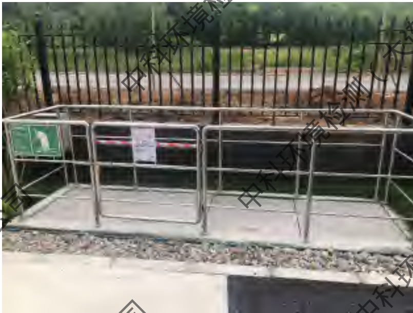
图 3-13 废水总排放口
