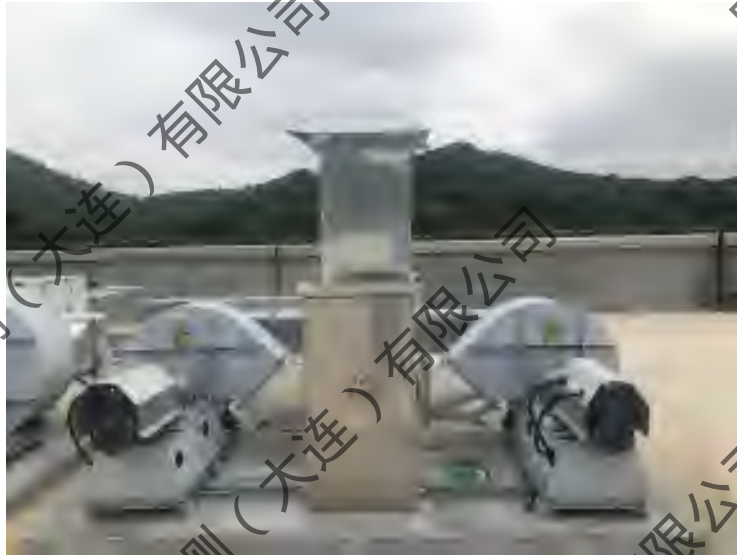
图 3-4 回流焊接炉排气口
