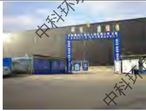
北侧奥特马在建工业锂电池隔膜涂布机项目
